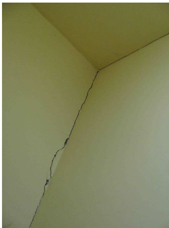
Fot 6 a) ściana działowa (WC); b) połączenie ściany działowej z ścianą zewnętrzną (WC)
